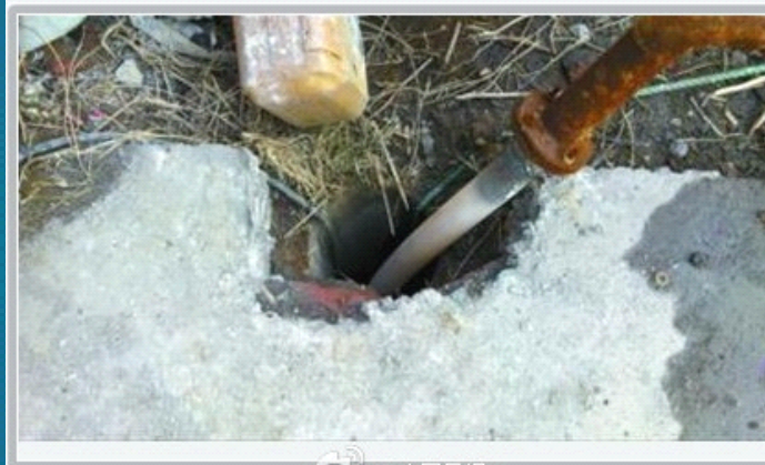
临朐某铝材厂内的疑似地下排污井，图中生锈钢管道右边连接的是两个污水池
